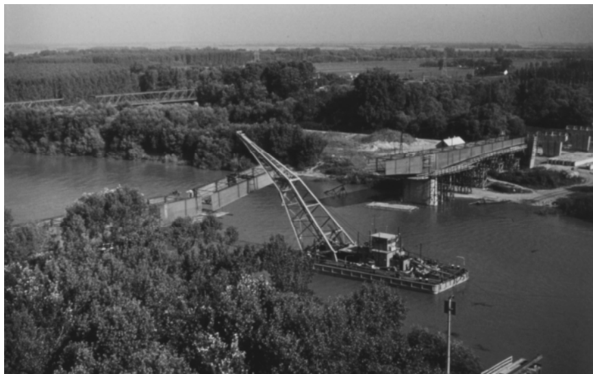
2. ábra Szabadszerelés (Fotó: Gáll Endre)
