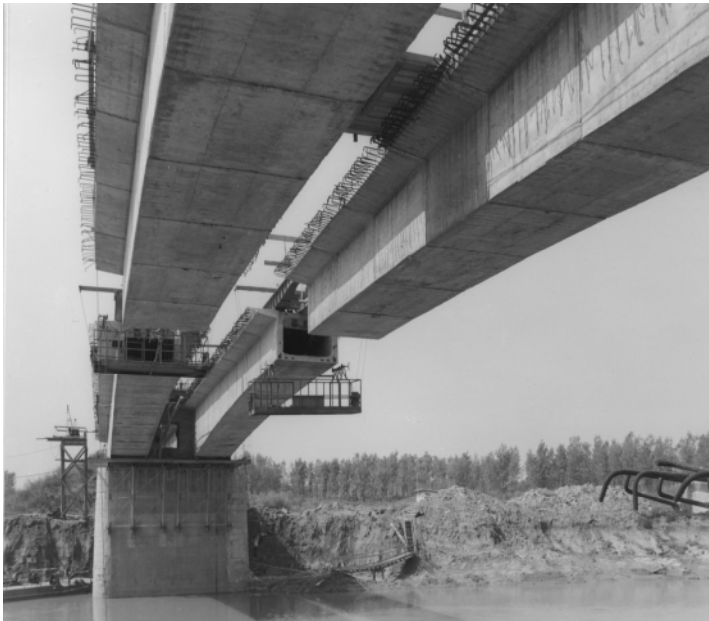
A kunszentmártoni Körös-híd építés közben
