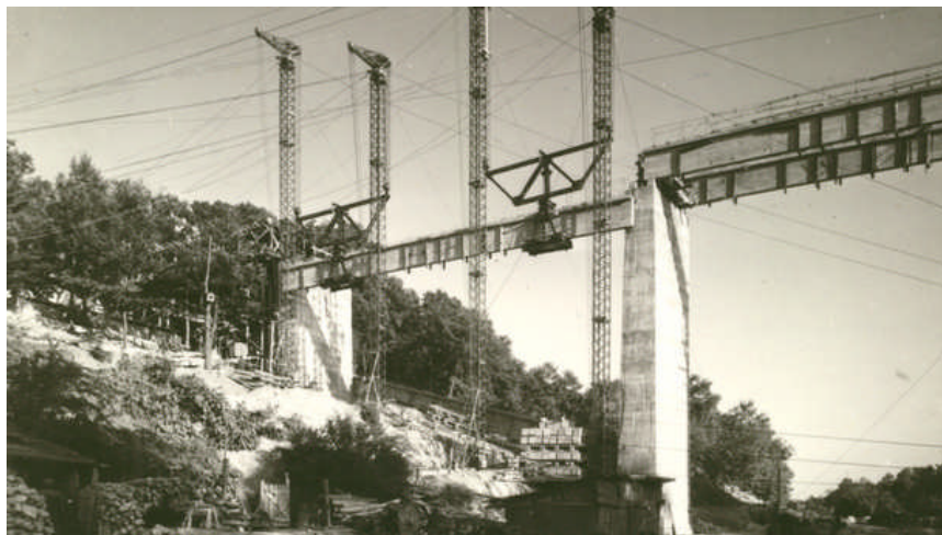
A Bolond úti völgyhíd építés közben
