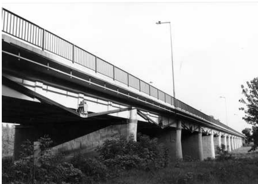
A megerősített szolnoki Tisza-ártéri-híd
