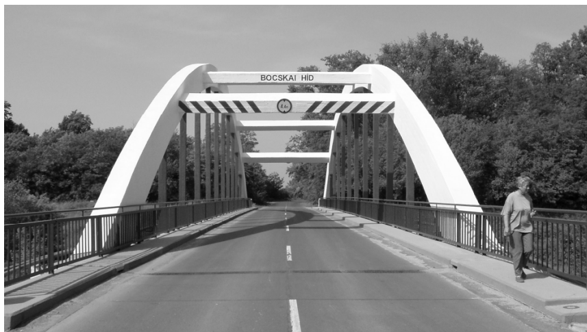
A tiszalöki Bocskai KFCS-híd
