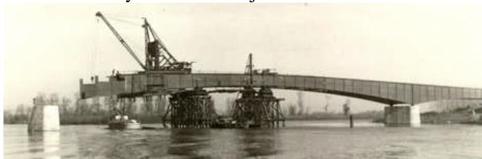
A tokaji Erzsébet királyné Tisza-híd építés közben
