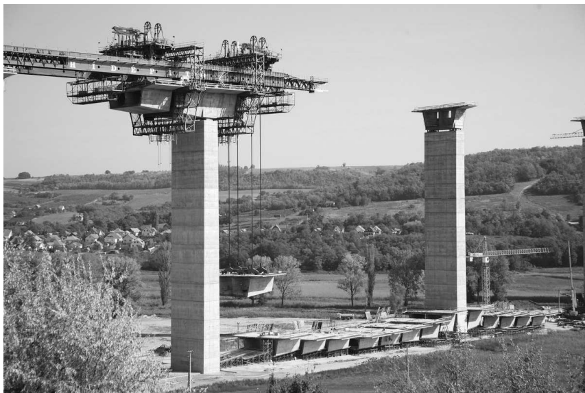
A kőröshegyi völgyhíd építése
