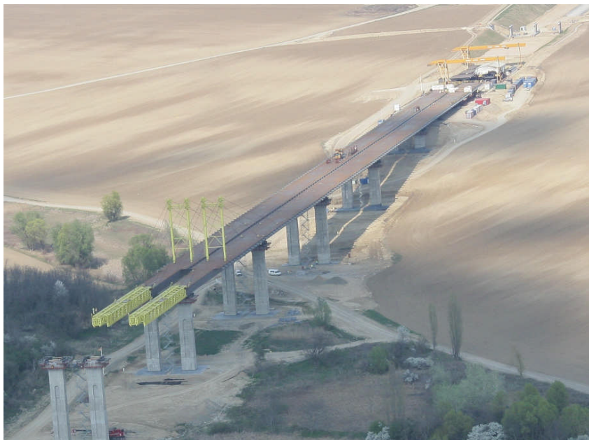
16. kép Az épülő hídszerkezet madártávlatból
