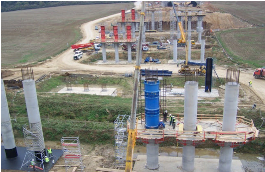
6. kép Az 1703 jelű völgyhíd pilléreinek zsaluzása, előtérben a középső 6. támasz 150 cm átmérőjű pilléroszlopainak építése
