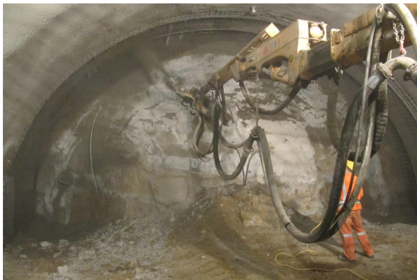
15. ábra Talajszilárdítás a mélyben
