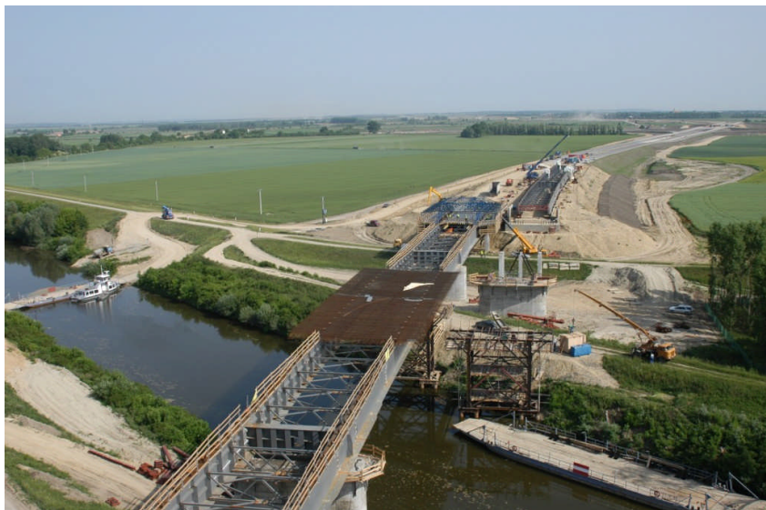
8. kép A Sió-híd építés közben (2009. május 18.)
