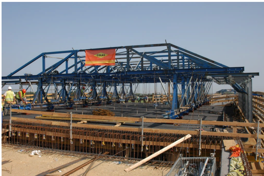
9. kép A Sió-híd déli zsaluzó kocsija betonozás előtt
