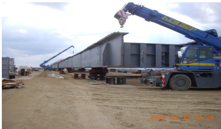
6. kép A Sió-híd jobb pálya acélszerkezete a szerelőtéren
