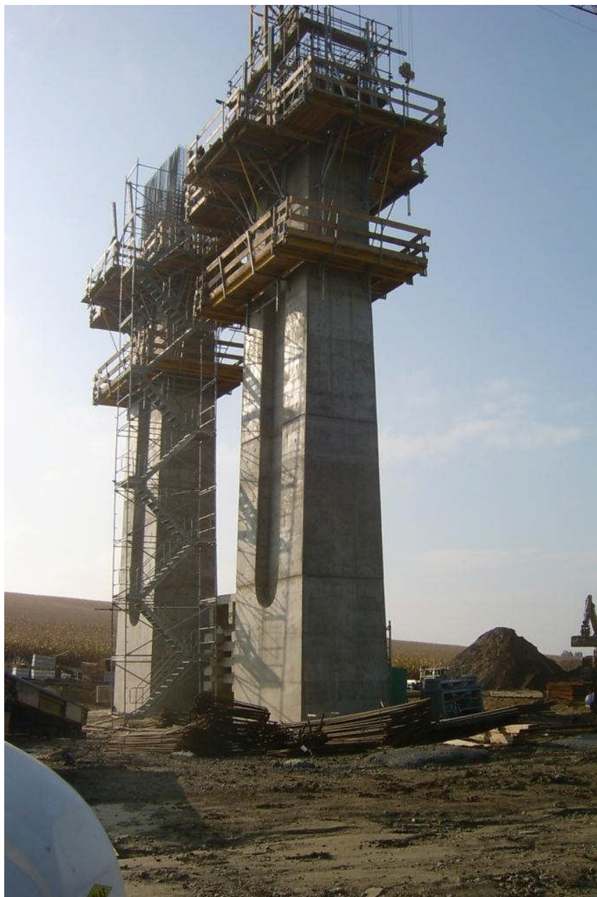
7. kép A DOKA MF kúszózsalu építés közben
