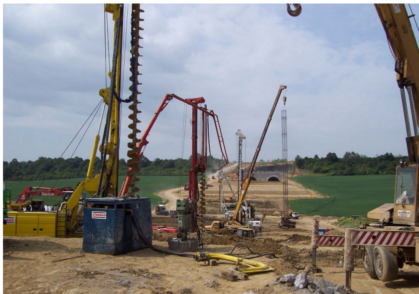
5. kép Az 1703 jelű völgyhíd alapozása Ø80 SOB cölöpökkel
