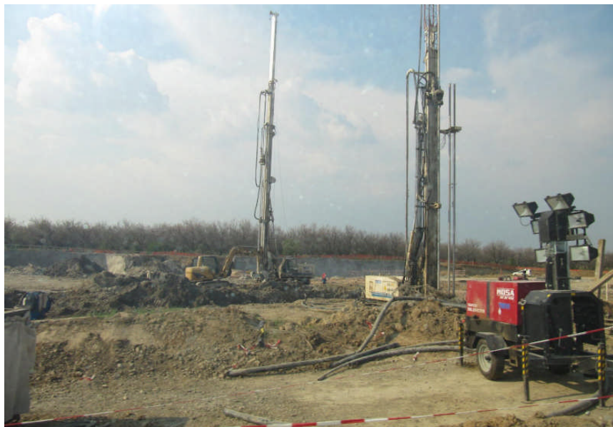
14. ábra Jet Grouting készítése a felszínről
