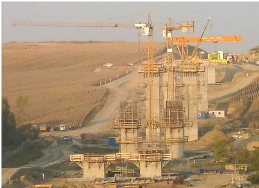
4. kép Felmenő szerkezetek építése
