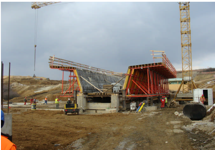
2. kép Az 1693 jelű völgyhíd gyártópádja
