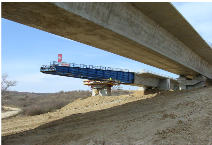
4. kép Megkezdődött az 1693 jelű völgyhíd jobb pálya felszerkezetének tolása a 34 m hosszú szerelőcsőrrrel
