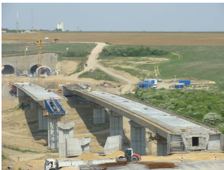
1. kép Az 1693 jelű völgyhíd építése
