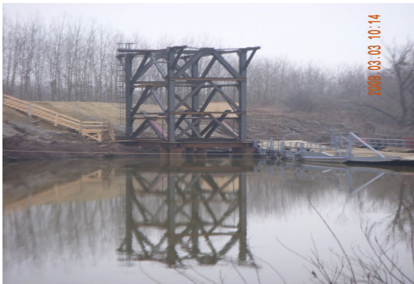
5. kép A Sió-híd középső nyílásának J2 jelű ideiglenes alátámasztó járma
