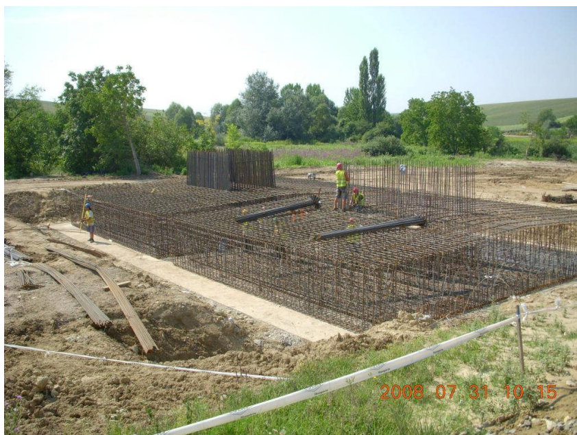
4. kép Cölöpösszefogó szerkezet vasszerelése
