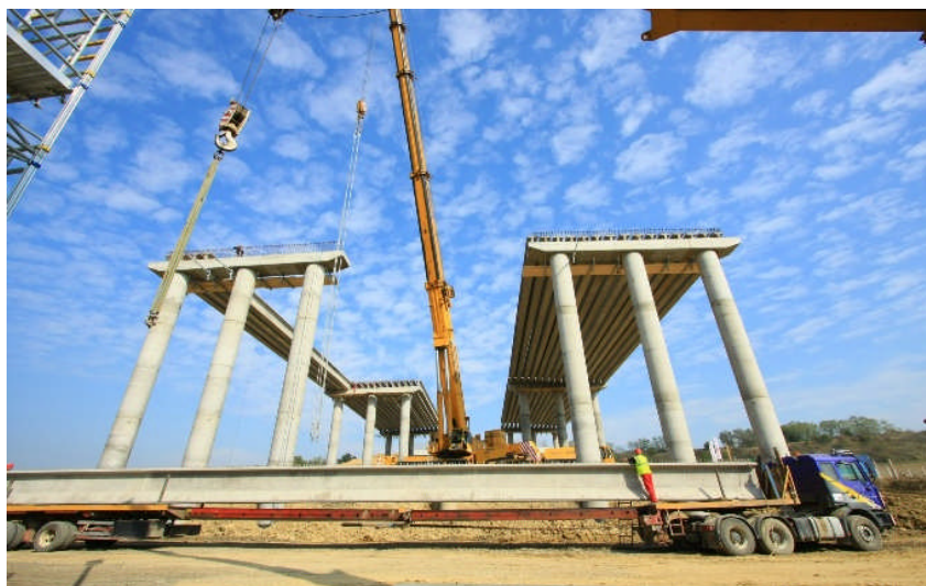
7. kép Az 1703 jelű völgyhíd gerendáinak beemelése
