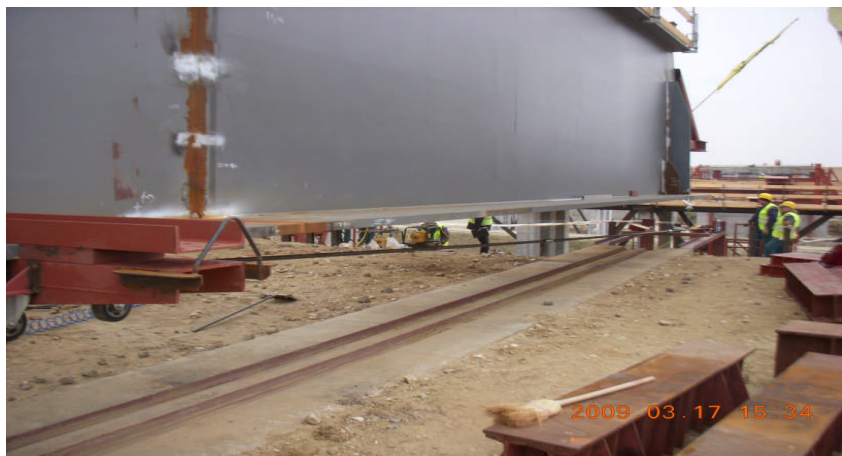
7. kép A Sió-híd jobb pálya húzása
