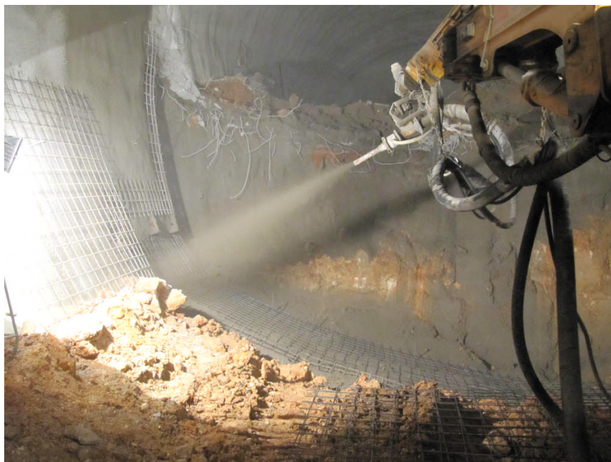
8. ábra Szórófej és az ellenboltozat betonozása
