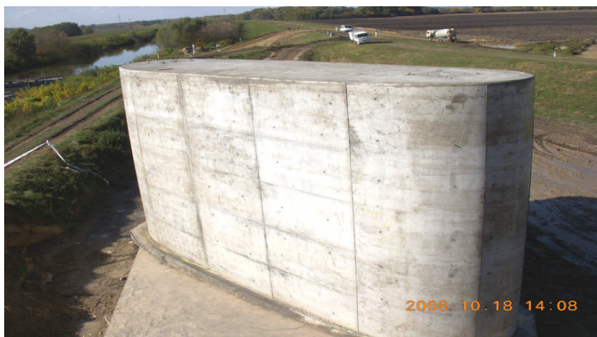
4. kép A Sió-híd ovális alaprajzú közbenső támasza
