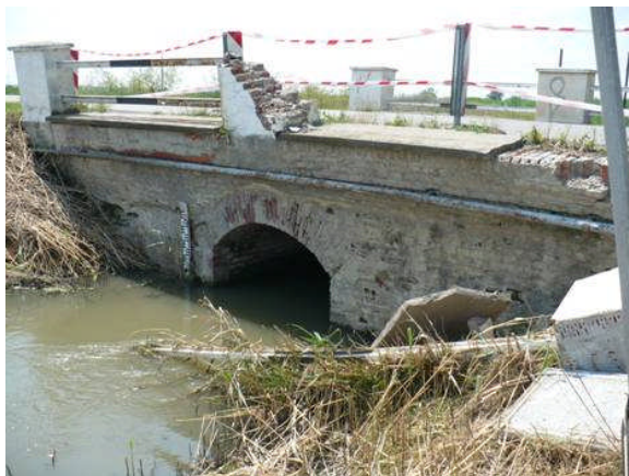
A 34103 j. karcagi bekötő úton 2008-ban téglavédőfal beomlás, majd acél szalagkorlát kihelyezése
