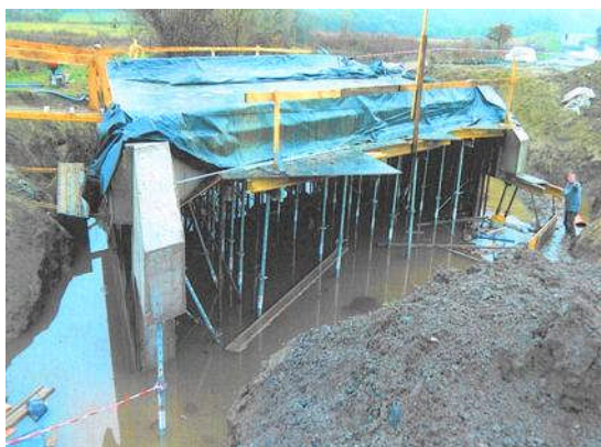
A kész szerkezet szigetelés előtt
