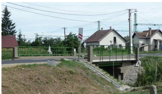
Az újszászi Holt-Tápió-csatorna-híd felújítása
