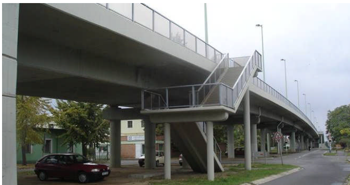
Orosházi (Békéscsaba – Szeged) vasút feletti híd
