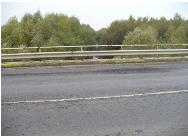
Az újszászi Zagyva-híd szegélye és pálya burkolata
