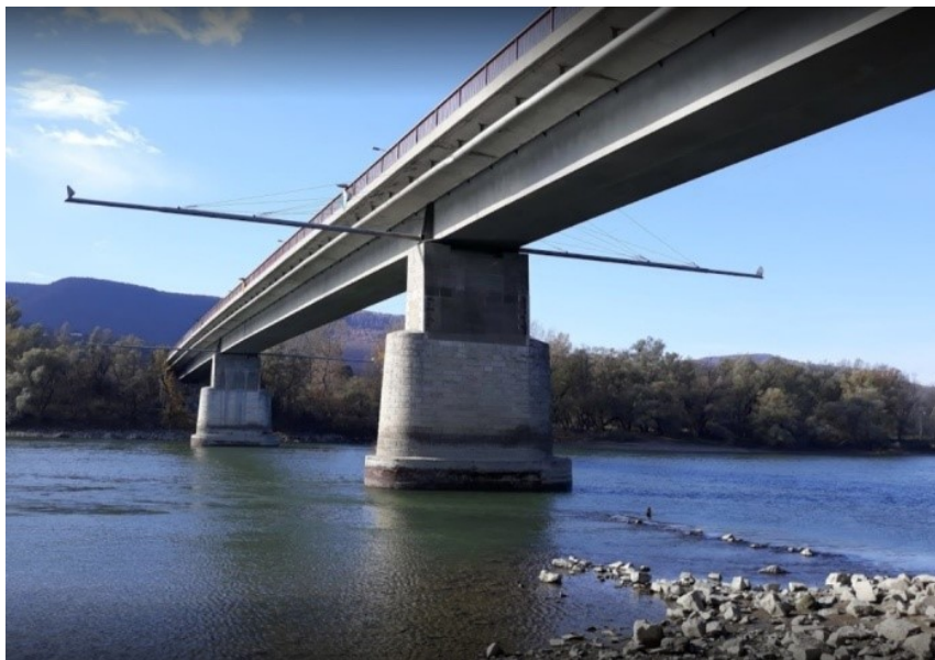
55. ábra: A tahitótfalui Szentendrei-Dunaág-híd 2014-ben
