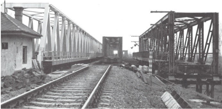
20. ábra: Az algyői vasúti Tisza-ártéri-híd behúzása (szélső régi nyílás kihúzva, balra az új ártéri folytatatólagos felszerkezet)
