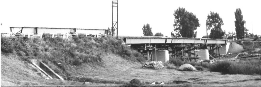
37. ábra: A berettyószentmártoni Berettyó-híd acél szekrénytartójának szerelése
