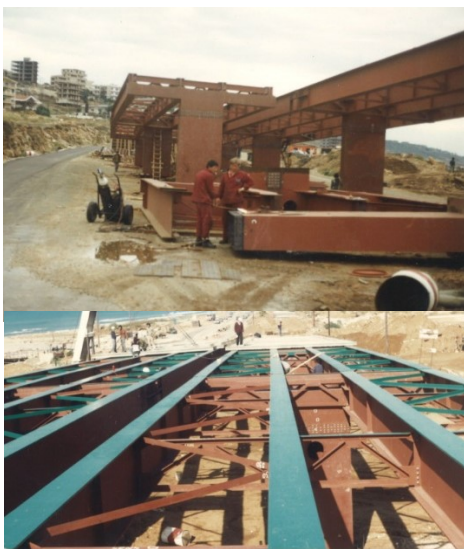
77. ábra: Khalde-híd szerelése
