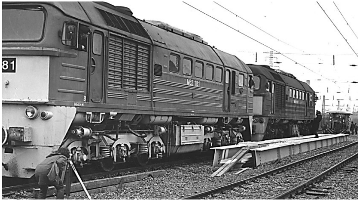
27. ábra: Budapest, Üllői út feletti vasúti híd egyik szerkezetének próbaterhelése
