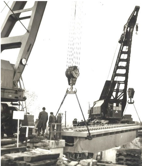
9. ábra: A bősárkányi Rábca-híd beemelésre előkészítve
