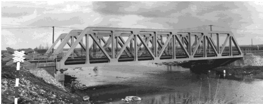
13. ábra: Az új hidak nem sokkal az átadás után
