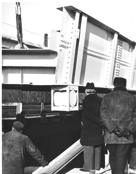
26. ábra: Budapest, Üllői út feletti vasúti hidak beemelése vasúti darukkal
