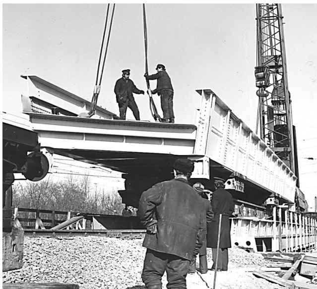
25. ábra: Budapest, Üllői út feletti vasúti hidak beemelése vasúti darukkal
