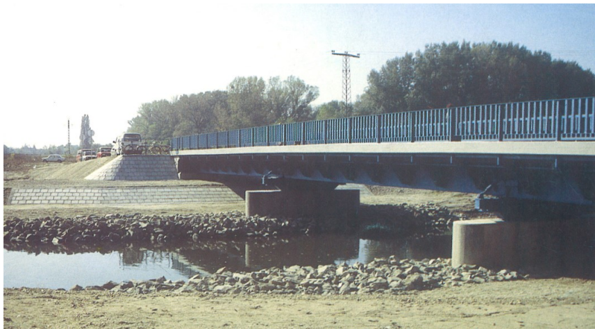
61. ábra: Mosonmagyaróvár Kiserdő utcai Lajta-híd megépült háromnyílású felszerkezete ESB-16 provizóriumból
