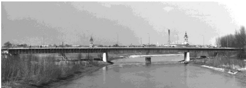
42. ábra: A győri Béke Rába-híd a segédjármok és a zsaluzat részleges elbontása közben
