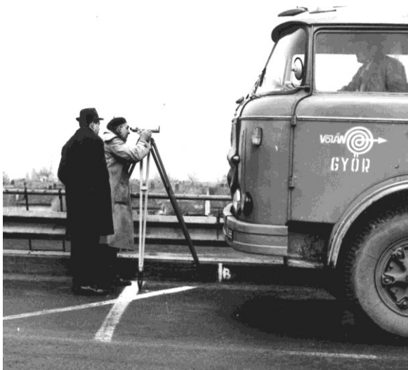
44. ábra: A győri Béke Rába-híd próbaterhelése (Darvas Endre -balra és dr. Szittner Antal – jobbra, színtezővel)
