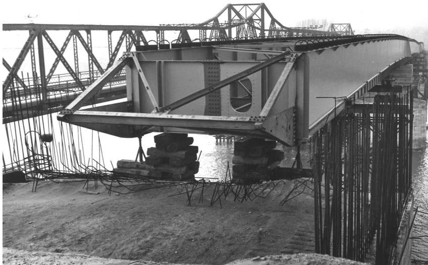
54. ábra: A tahitótfalui Szentendrei-Dunaág-híd hosszirányú behúzása
