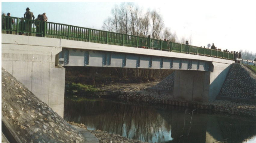
62. ábra: Börcsi Rábcs-híd ESB-16 jelű provizóriumok toldásával készített felszerkezete az átadáskor
