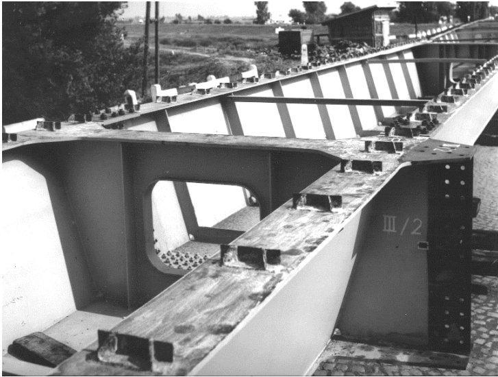
38. ábra: A berettyószentmártoni Berettyó-híd acél szekrénytartójának szerelése
