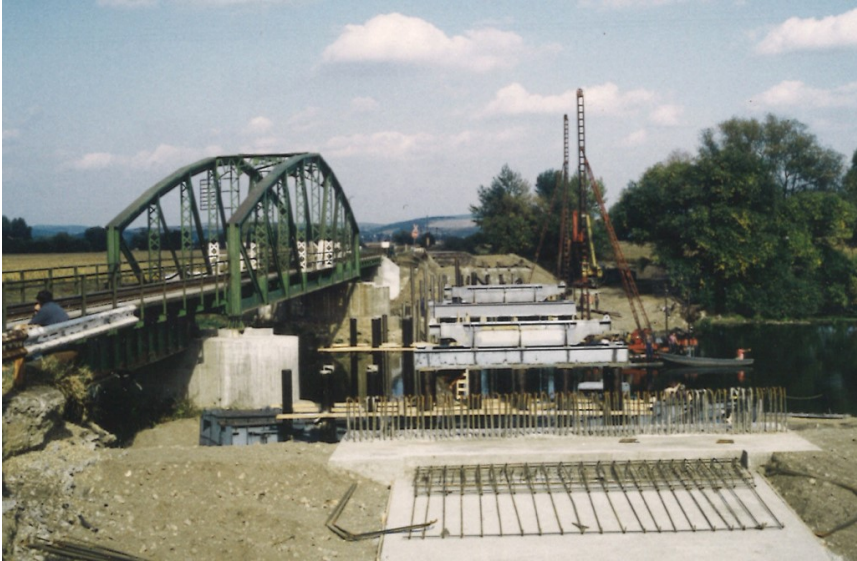
59. ábra: Sajóecsegi Sajó-híd építés közben (balra a vasúti híd)
