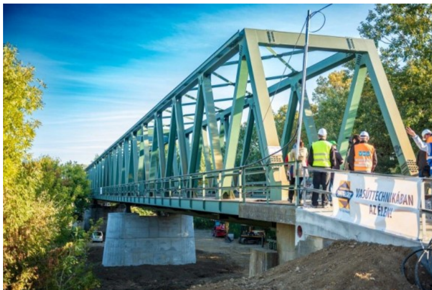
22. ábra: Az algyői vasúti Tisza-ártéri-híd felújítása 2018-ban
