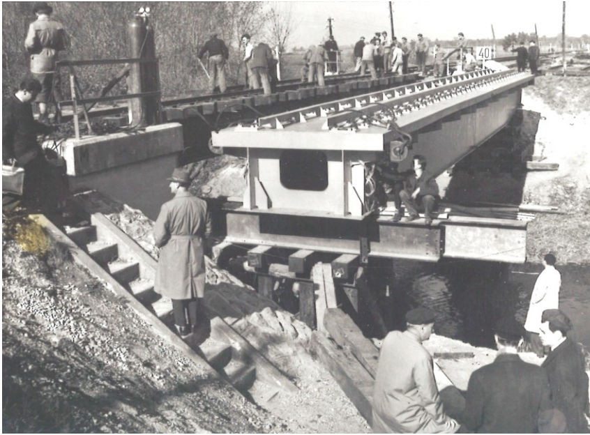
9. ábra: A bősárkányi Rábca-híd beemelésre előkészítve
