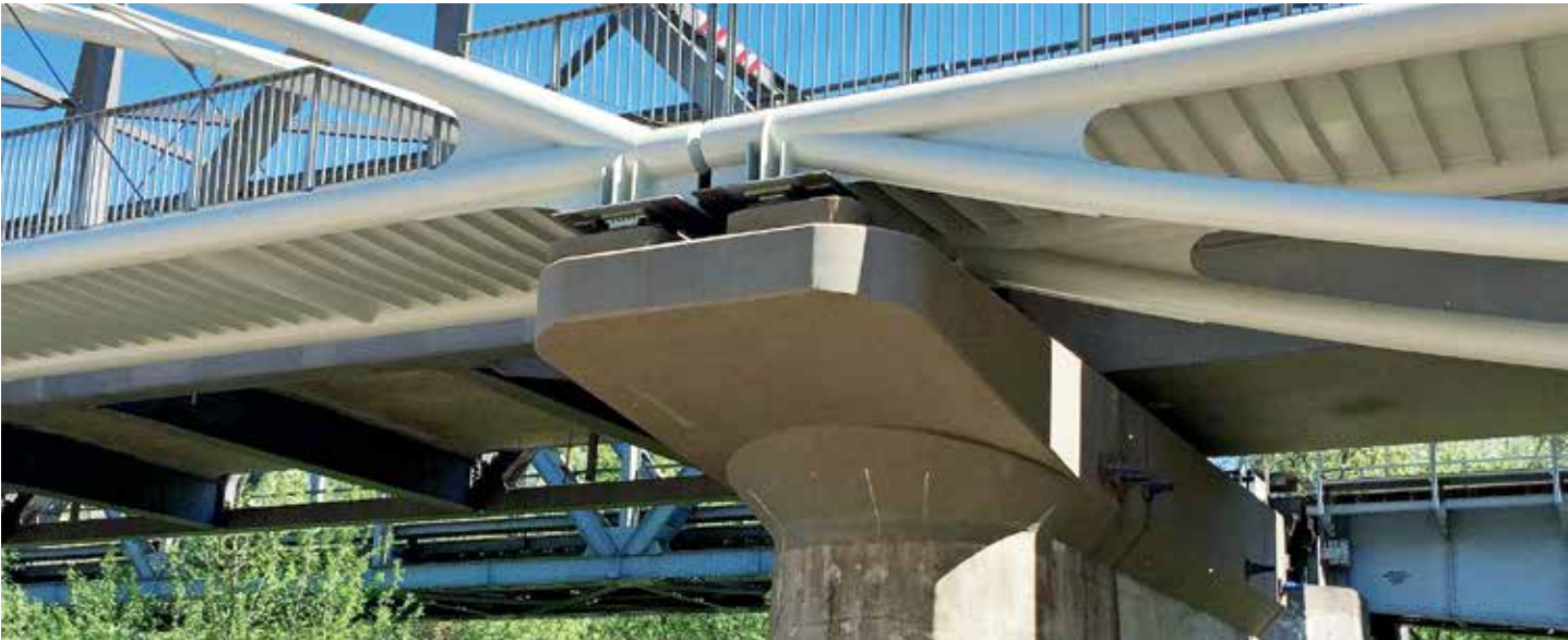
68. kép – Tisza-híd elkészült fejgerenda
