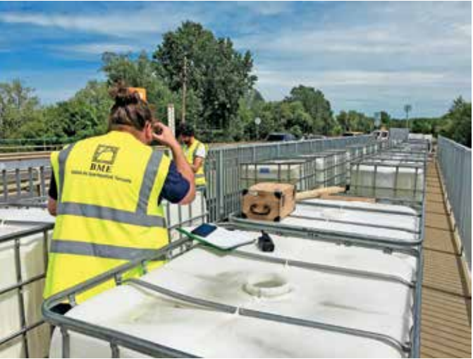
92. kép - Szomorka-patak híd statikus próbaterhelése
