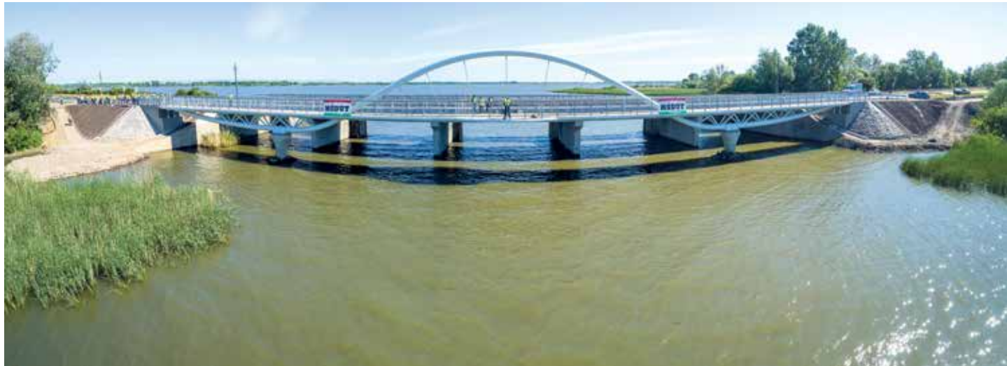
63. kép - Szomorka-patak híd szerkezete a víz felett
