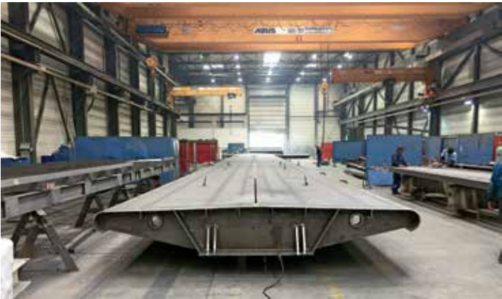
54. kép - Szomorka-patak híd pálya próbaszerelése
