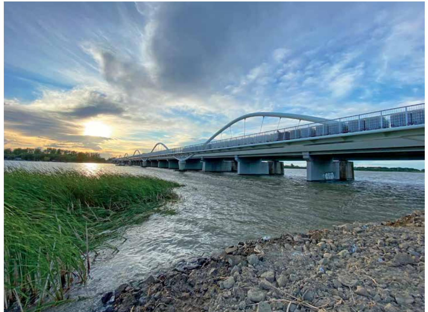
64. kép - Eger-patak híd
