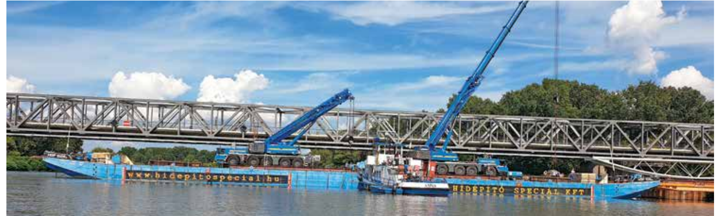
77. kép - 200t teherbírású daruk beléptetése a TS40 bárkákra
