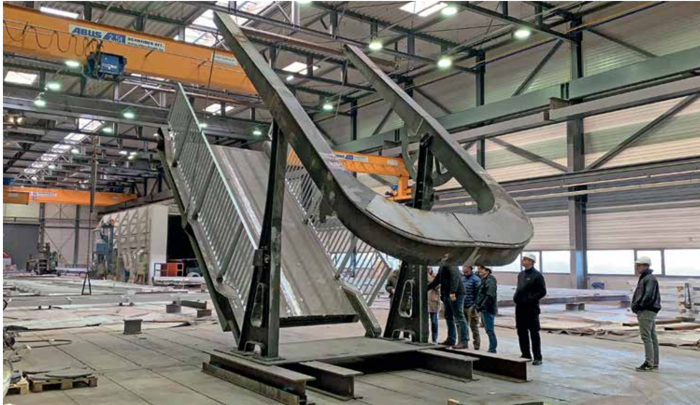
84. kép - X. Öblítő híd üzemi próbaszerelése
