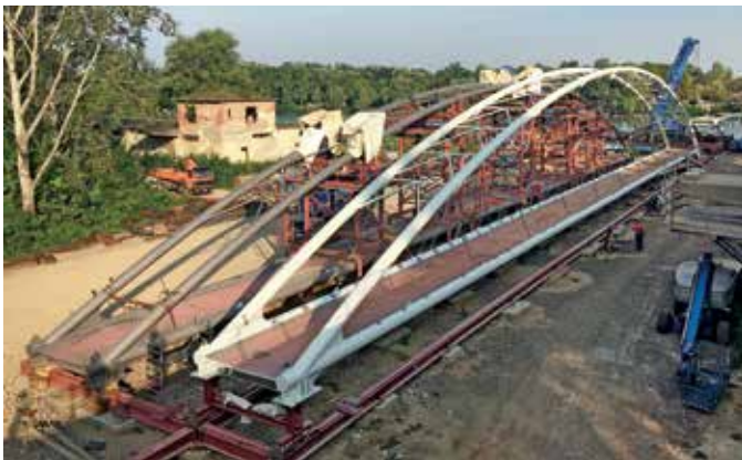
76. kép - Tisza híd TM1 és TM2 mederelem a szerelőtérén
