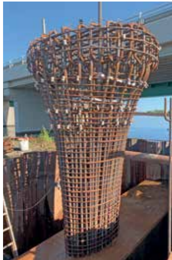
48-49. kép - Pillér vasalása és a kiszaluzott vasbeton szerkezete
