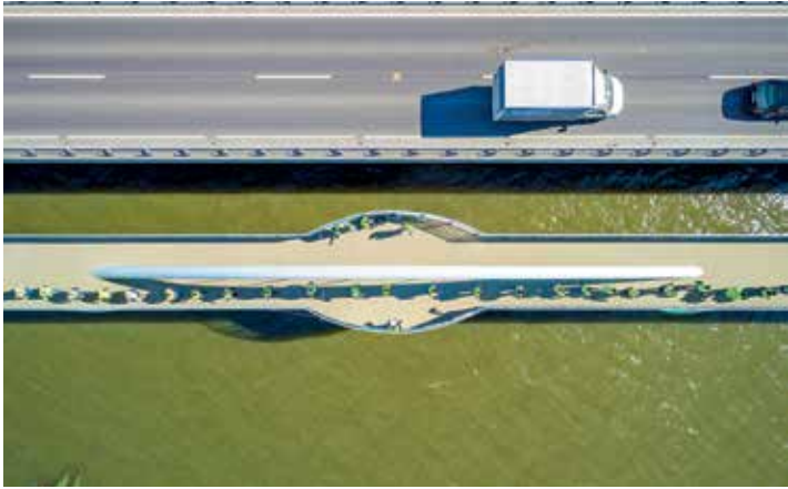
89. kép - Szomorka-patak híd dinamikus próbaterhelése felülnézetből
