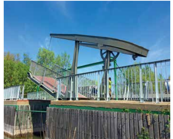
86. kép - A megvalósult X. Öblítő híd felnyitás közben
