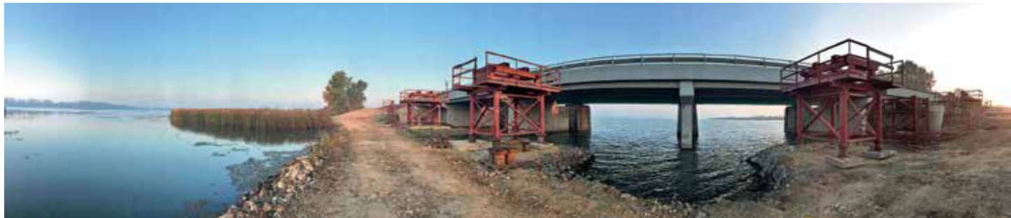
59. kép - Szomorka-patak híd betöltés és szerelőterület
