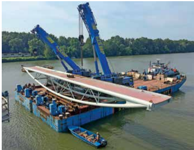
79. kép - Tisza-híd szélső nyílás szállítása a szerelőtérrel a csárda melletti támaszhoz
