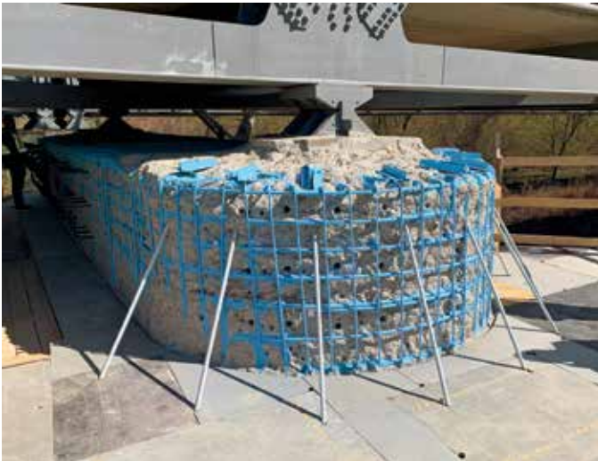
65. kép – Tisza-híd fejgerenda visszavésés
