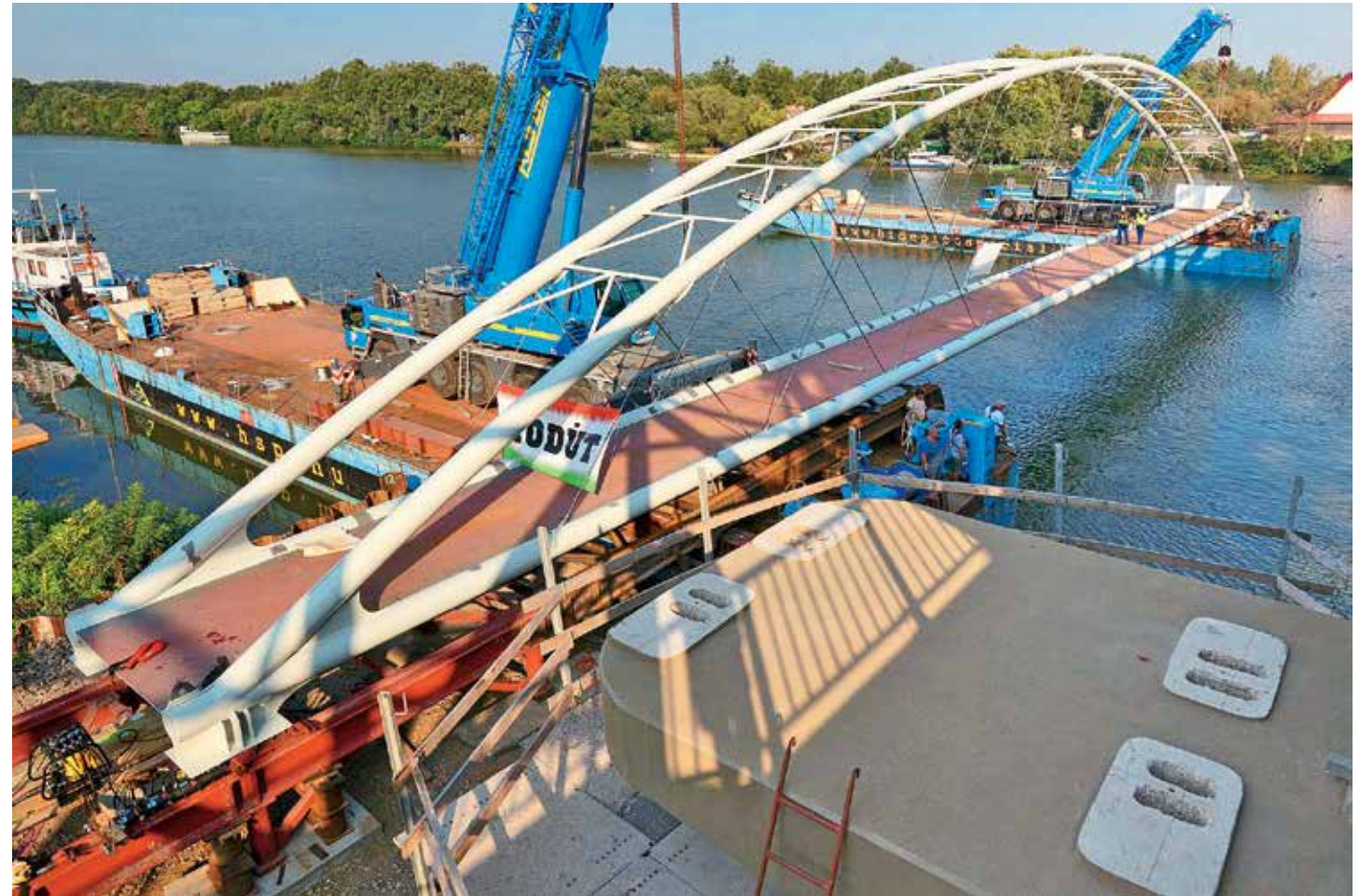
80. kép - Tisza híd első mederelem beúsztatása
