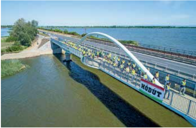
87. kép - Szomorka-patak híd dinamikus próbaterhelés Hódút Kft. kollégáinak közreműködésével
