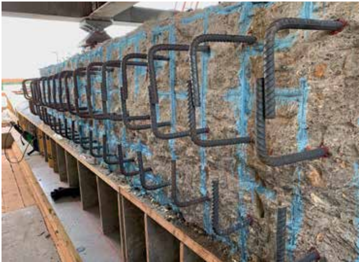
66. kép – Tisza-híd fejgerenda tüskézés
