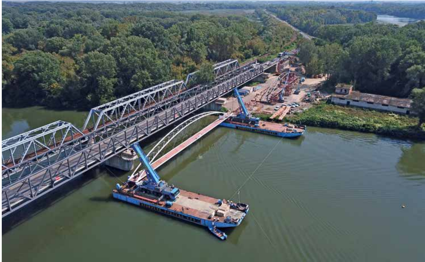
81. kép – Tisza híd első mederelem beúsztatása
