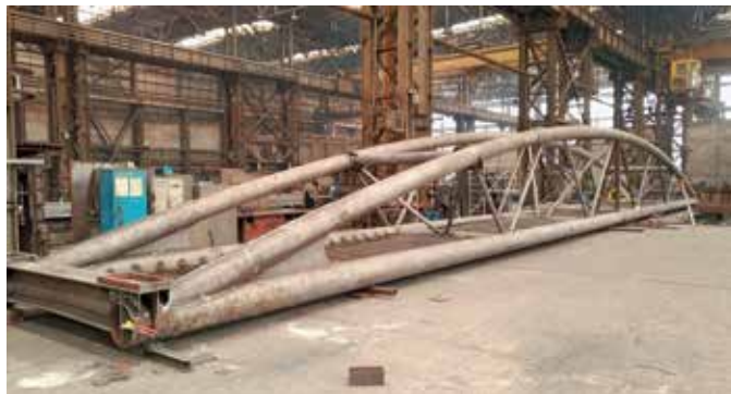
69. kép - Tisza híd ártéri elem próbaszerelése fejtetőre állítva
