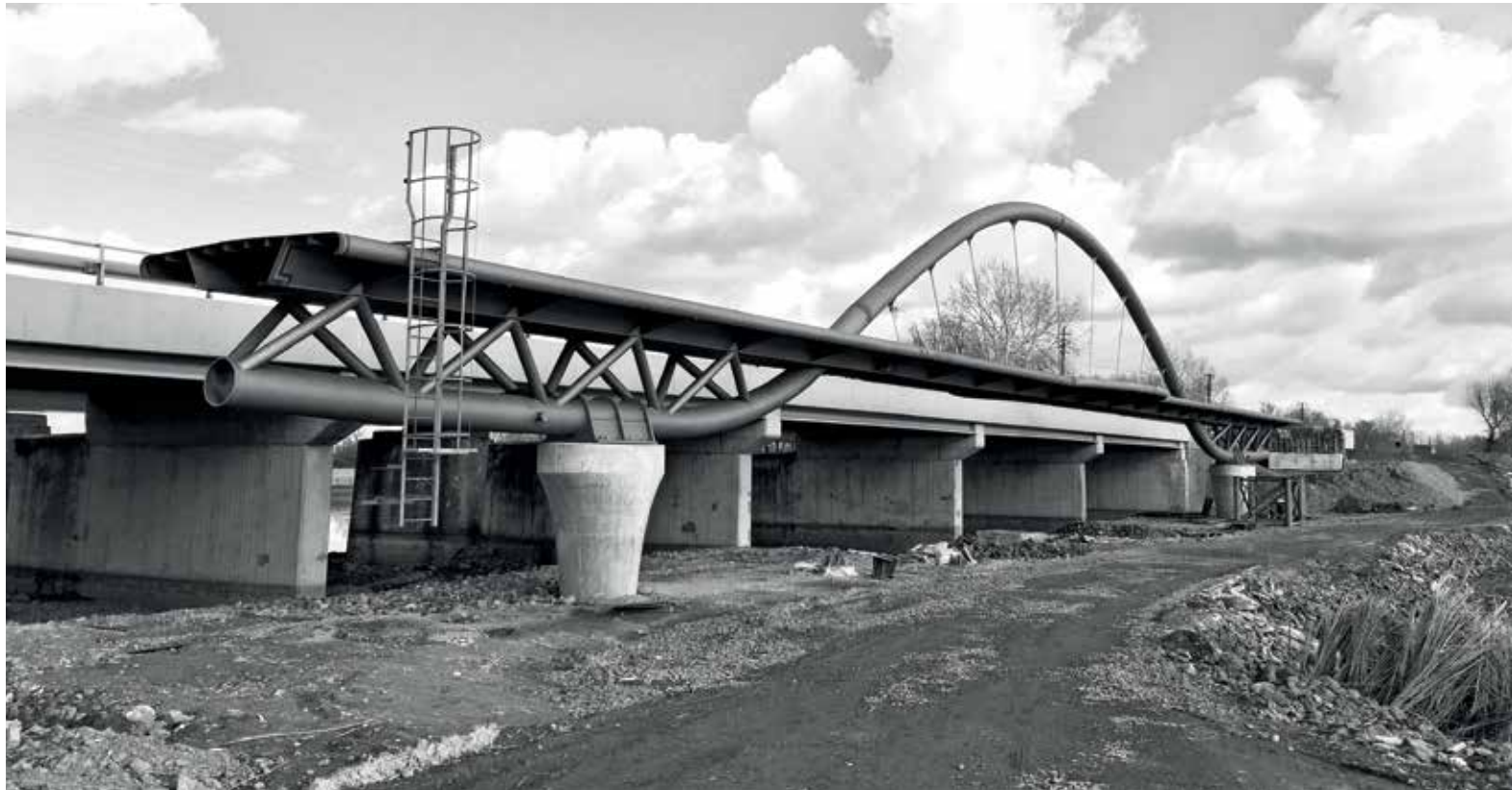
58. kép - Szomorka-patak híd építés közben
