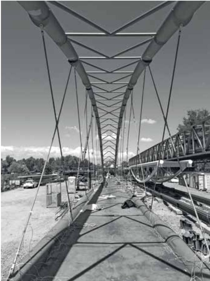
75. kép - Tisza híd meder elem rúdfeszítés folyamatban
