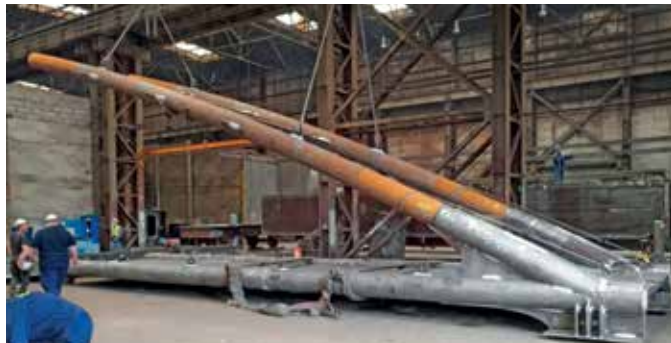
70. kép - Tisza híd meder elem próbaszerelése
