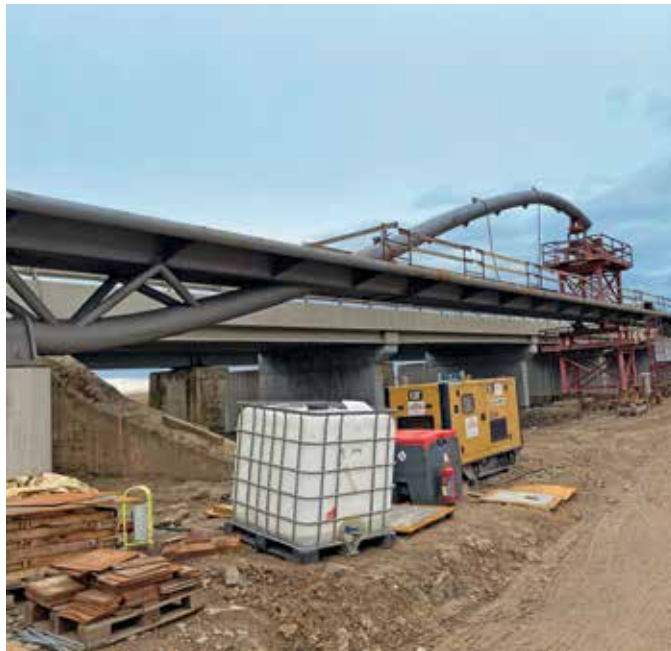
62. kép - Eger-patak híd ívtartó szerelése
