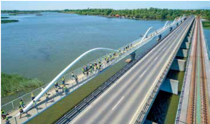
90. kép - Eger-patak híd dinamikus próbaterhelése
