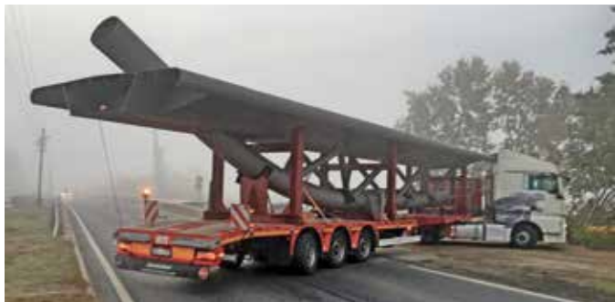
61. kép - Szomorka-patak híd T2 jelű elem érkezése
