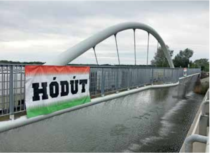
93. kép – Szomorka-patak híd statikus próbaterhelése
