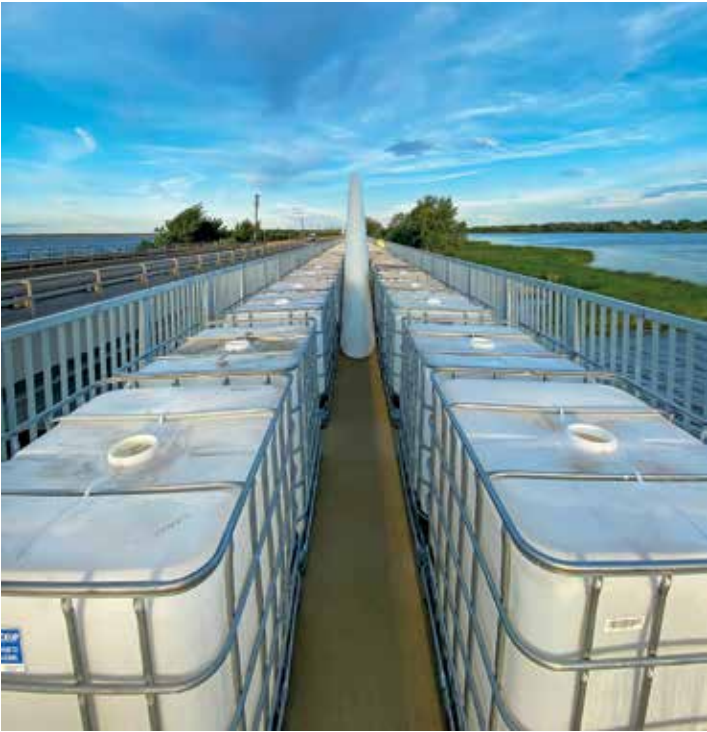
91. kép – Eger-patak híd statikus próbaterhelése
