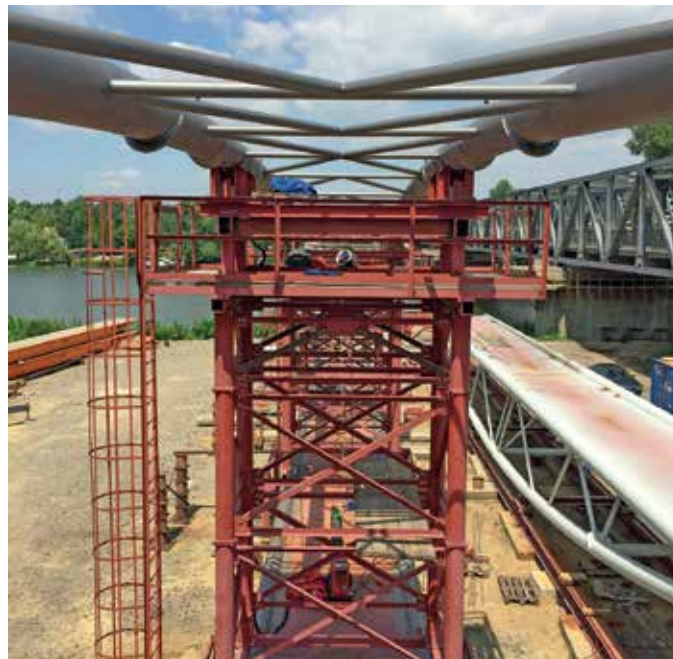
74. kép - Tisza híd meder elem szerelése
