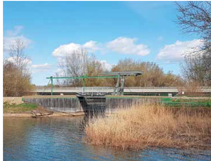
43. kép: X. Öblítő műtárgy – Ráépítés utáni állapot
