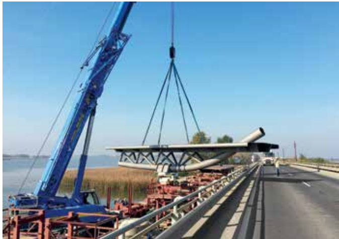
60. kép - Szomorka-patak híd T2 jelű elem beemelése
