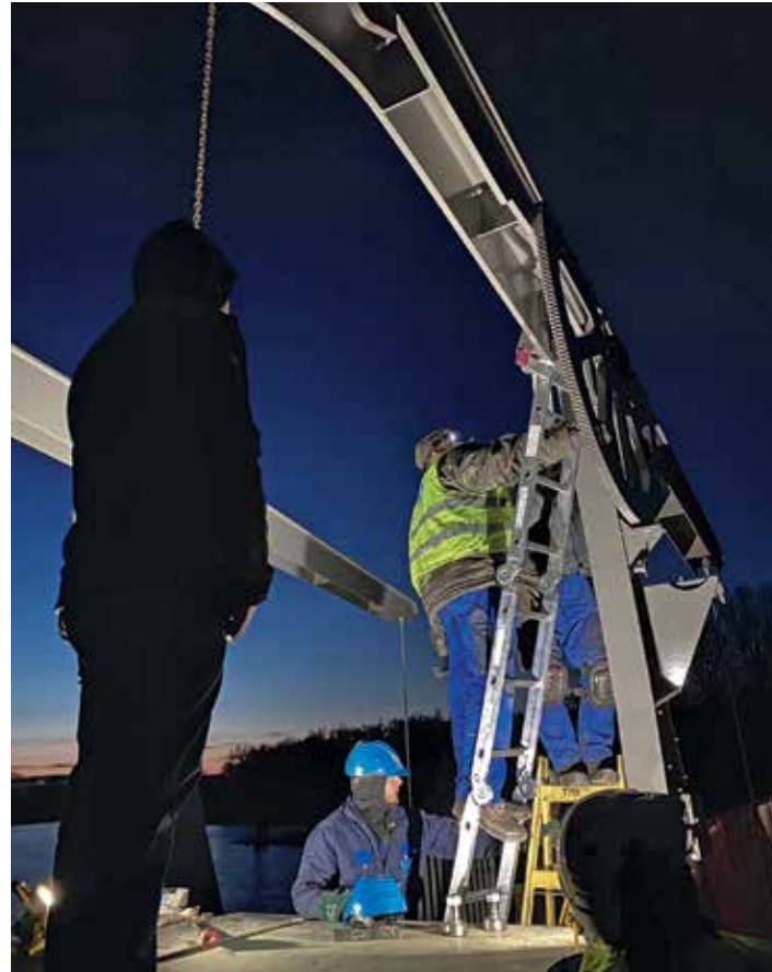
85. kép - A X. Öblítő híd helyszíni telepítése
