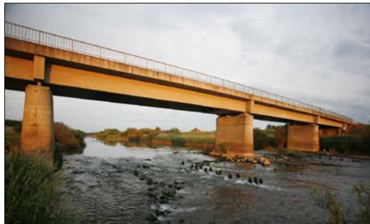
A Komádinál 1945 után épített felszerkezet már más, új stílust képvisel
