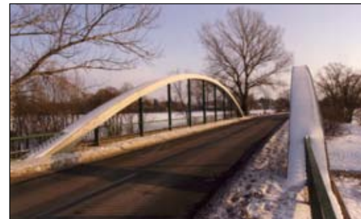
Kecskénél keresztelés nélküli ívhíd épült
