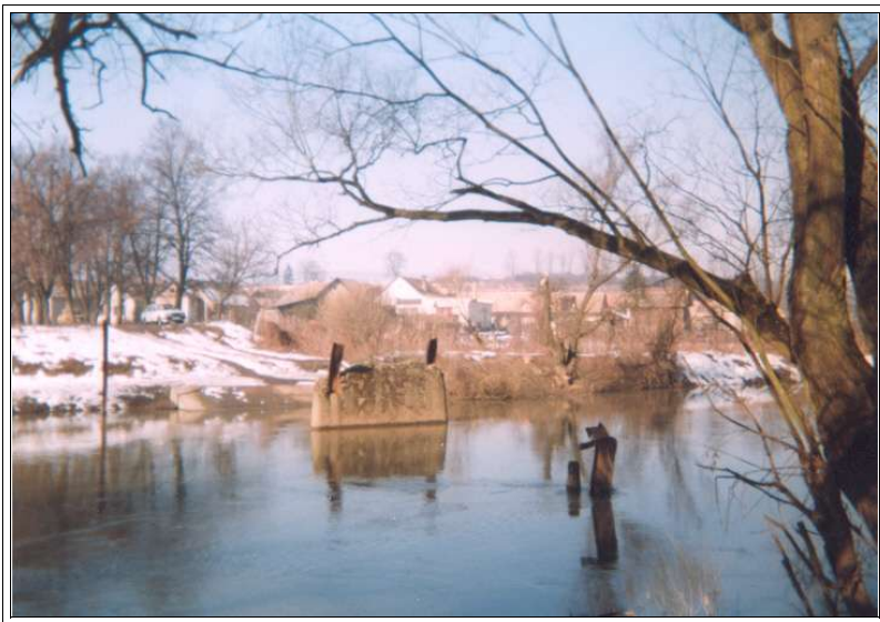
A múlyadi híd roncsai
