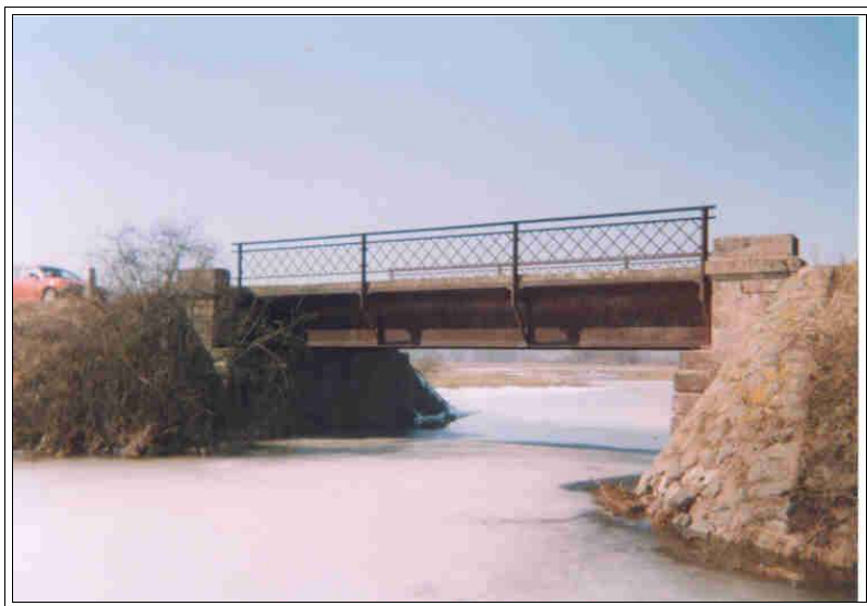
A húgyagi híd ártéri nyílása
